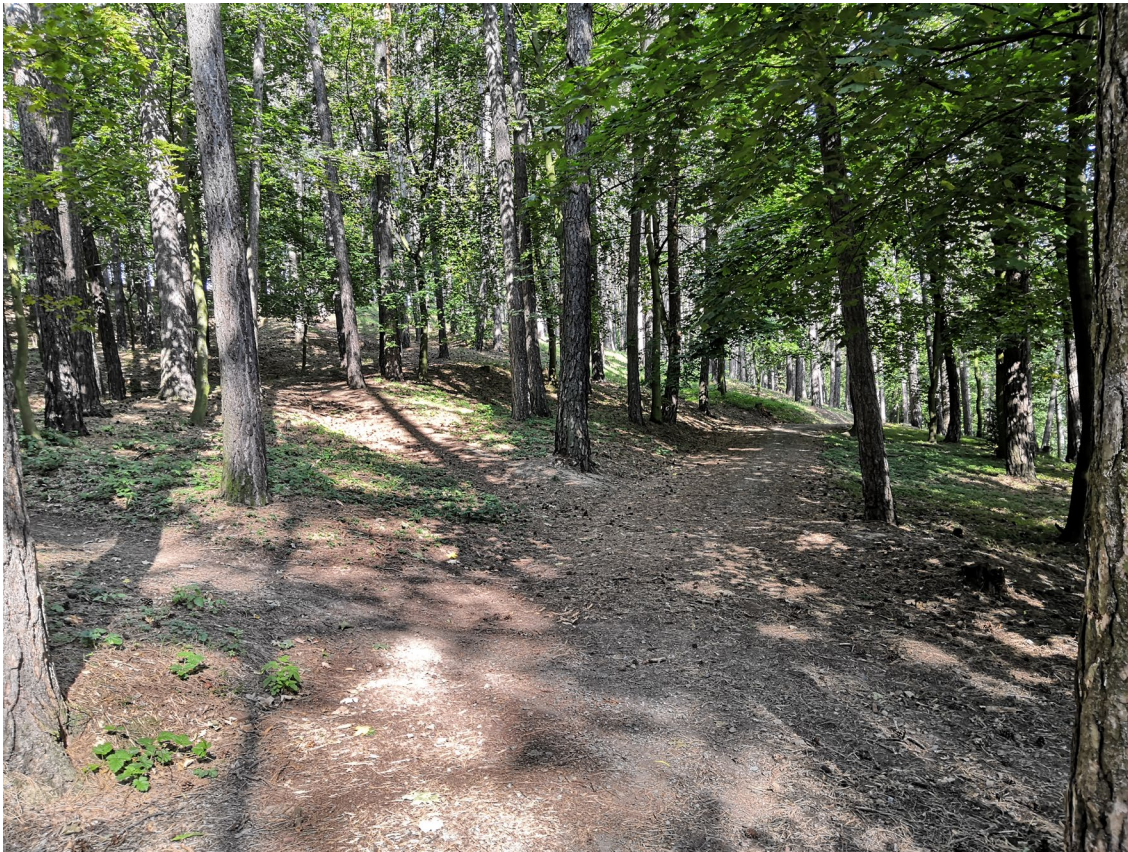
U většiny stávajících cest dojde pouze k povrchové úpravě a povrchovému vyrovnání dosypávkou štěrku.
