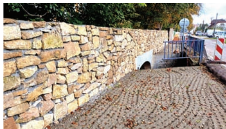
Oprava zámecké zdi
