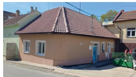
Oprava objektu „KEBAB HOUSE“
