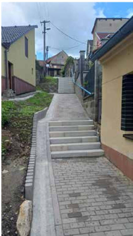
Oprava kanalizace a vodovodních přípojek Šraňky
